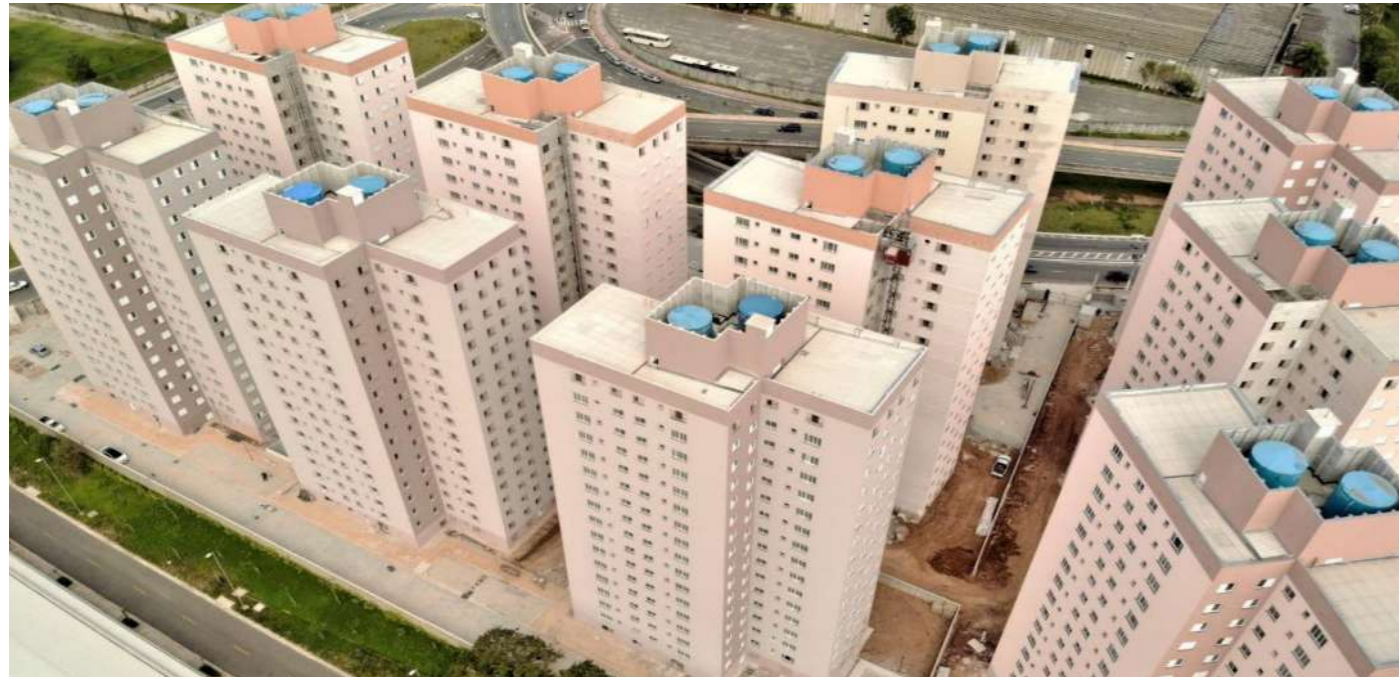
Viviendas Guido Caloi en la Zona Sur de São Paulo.
