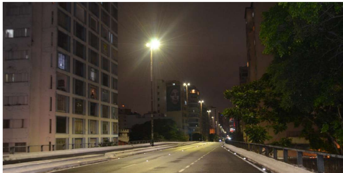
Instalación de luces LED en farolas de São Paulo.
