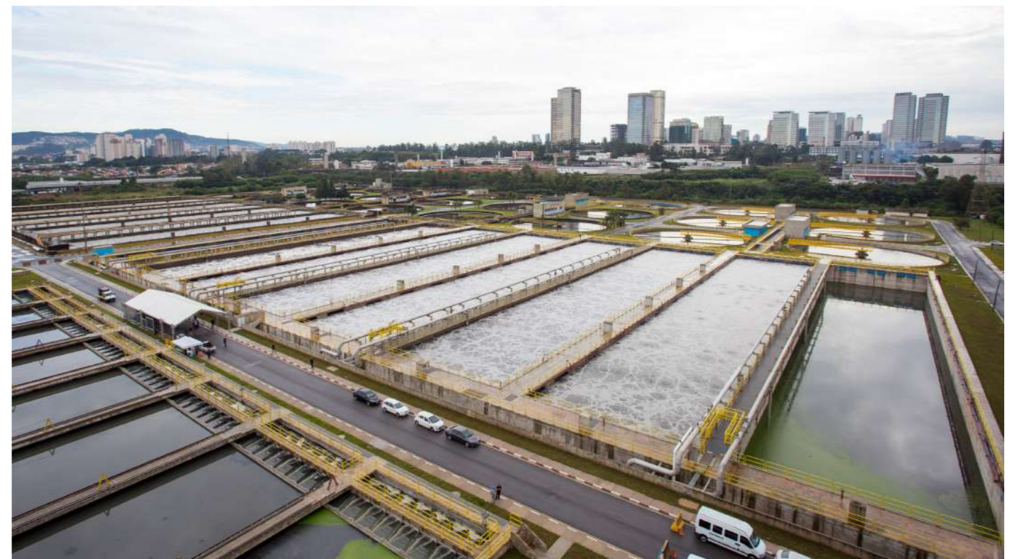
Estación de Bombeo de Aguas Residuales Piqueri.
