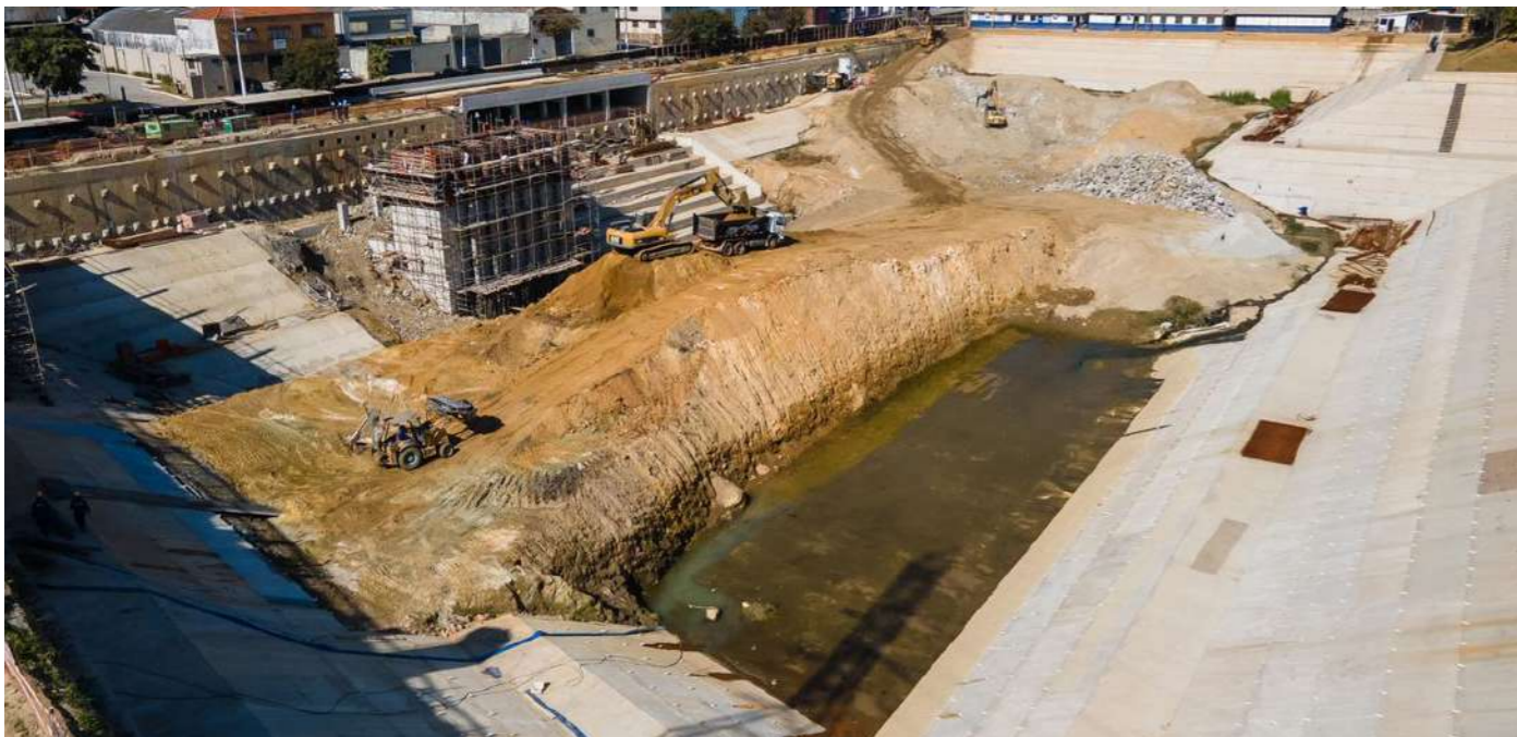
Construcción de la piscina Taboão en la Avenida Aricanduva.
